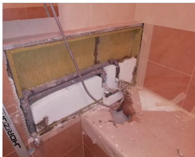
Obr. 1: Ukázka měření vodovodních instalací v bytovém domě – původní stav (vlevo), stav po akustických úpravách (vpravo)
