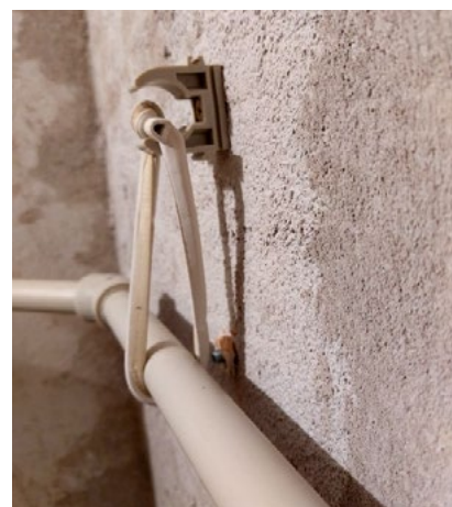
Obr. 3: Způsoby upevnění potrubí – PPR příchytky (vlevo), objímky s gumovou vložkou (uprostřed), volně zavěšené potrubí (vpravo).
